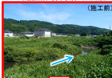
鳳至川における河道掘削、樹木伐採（石川県）
