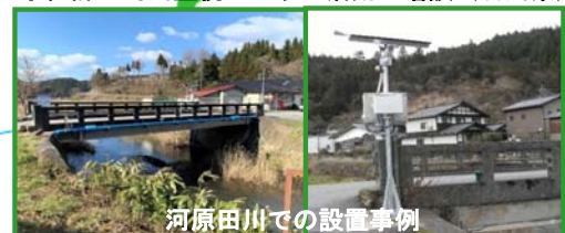
水位計・河川監視カメラの活用・増設（石川県）
