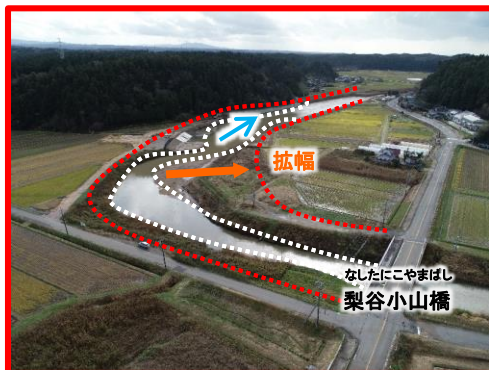
米町川における河川改修の実施（石川県）
