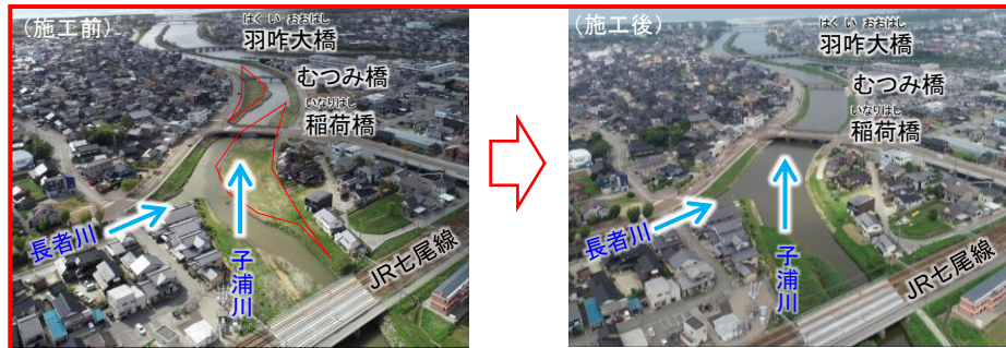
子浦川における河道掘削、樹木伐採 (石川県)
