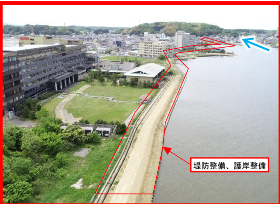
柴山潟における河川改修の実施（石川県）
