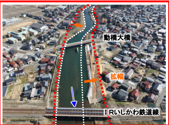
動橋川における河川改修の実施（石川県）
