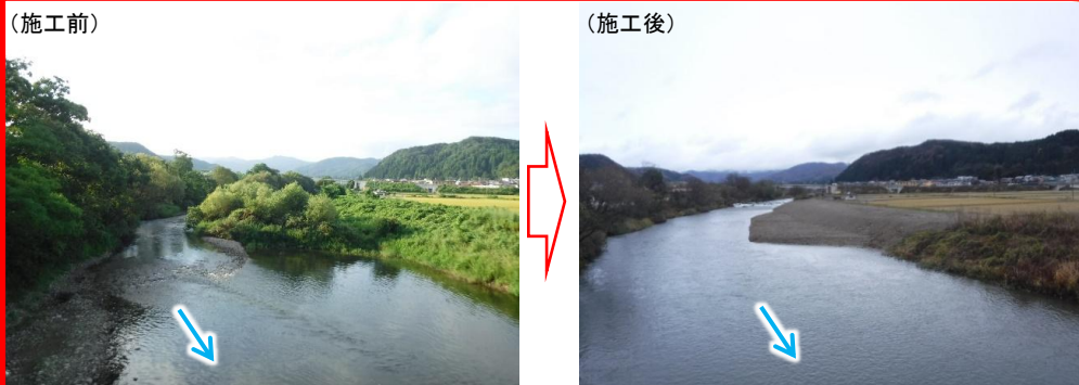
大聖寺川における河道掘削、樹木伐採（石川県）
