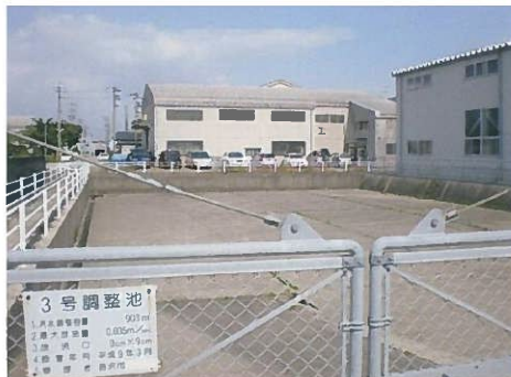
雨水貯留施設(調整池)
