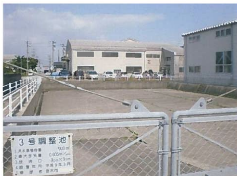
雨水貯留施設(調整池)
