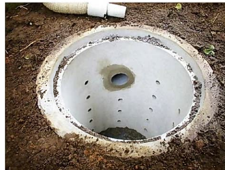
雨水浸透ます
