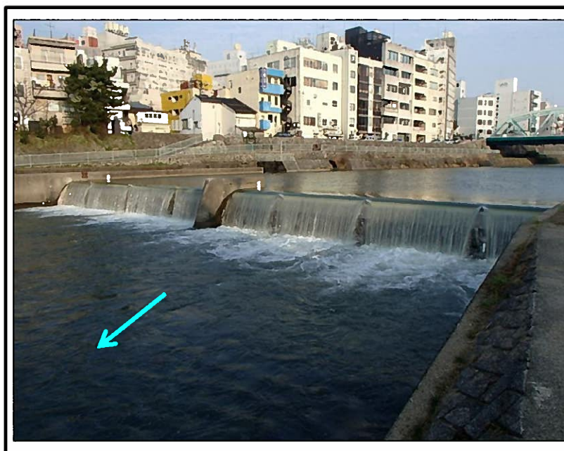
犀川 犀川転倒堰
