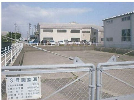
雨水貯留施設(調整池)
