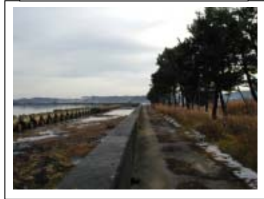
田鶴浜海岸田鶴浜地区の 消波堤
