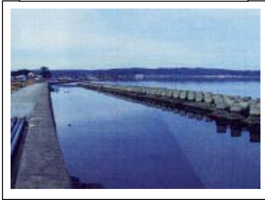
田鶴浜海岸白浜地区 の消波堤
