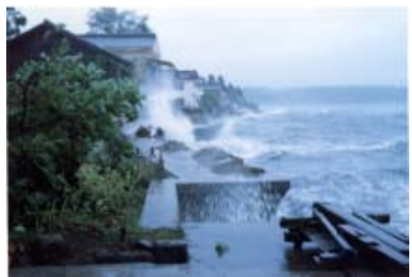
穴水海岸における宅地への越波状況 (昭和 58 年)
