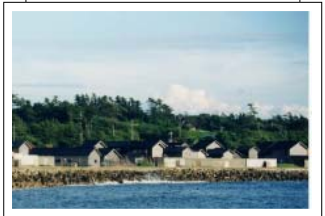
赤崎漁港海岸赤崎地区の道路護岸と消波工
