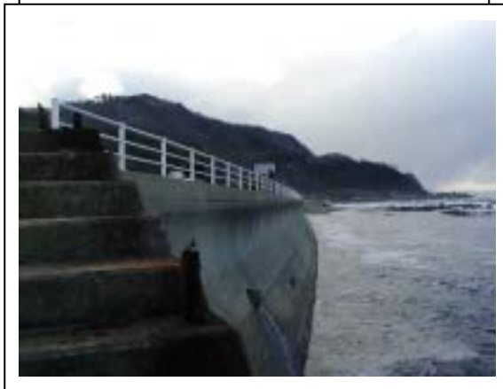
珠洲西海海岸清水・片岩地区の道路護岸
