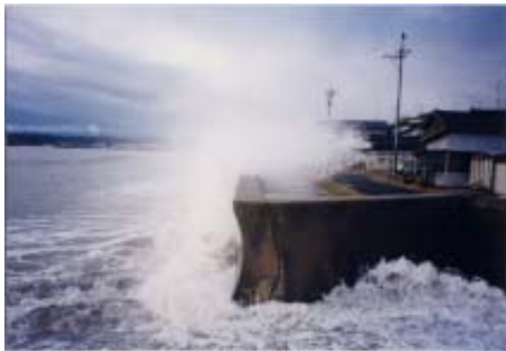
飯田港海岸野々江地区における宅地への 越波状況（平成 10 年 10 月台風 10 号）
