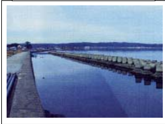
田鶴浜海岸白浜地区 の消波堤
