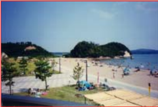
能登島マリンパーク(七尾港海岸久美地区) の階段護岸と養浜
