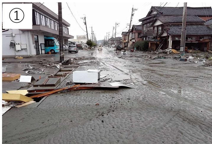
① 飯田港付近（珠洲市飯田町）
