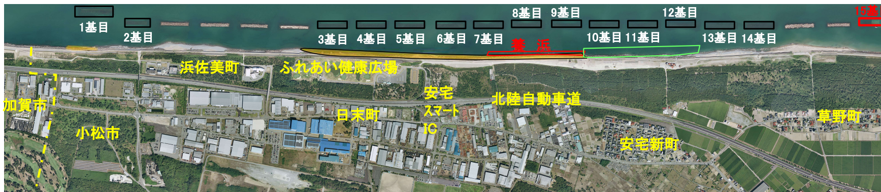
小松工区の事業実施状況(人工リーフ1基目~14基目:完成、15基目整備中)
