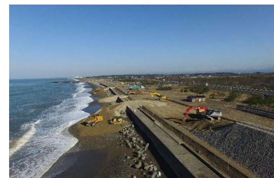
養浜施工状況
