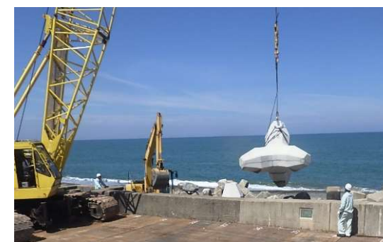
消波ブロック据付状況
