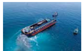
海上投入の実施状況 (砂の投入)
