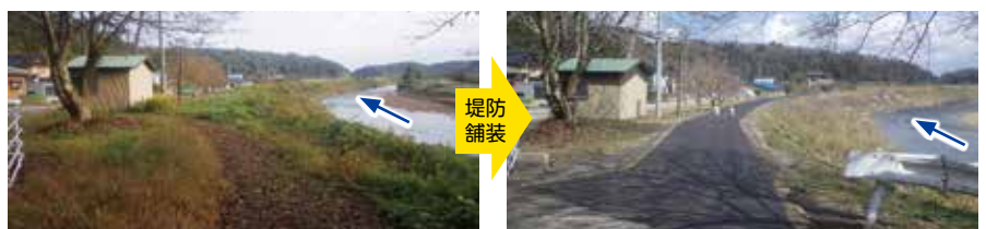
堤防強化の事例（梯川：小松市花坂町）
