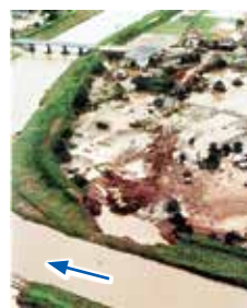
動橋川 →改修(河川拡幅、築堤)
