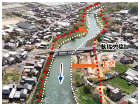
動橋川（動橋大橋付近の拡幅）
