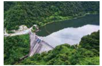
犀川ダム（金沢市） 制御処理設備の更新と併せて、ゲート設備の遠隔操作化を実施中
