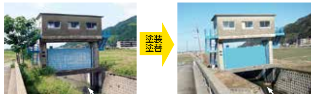
扉体の腐食防止対策
