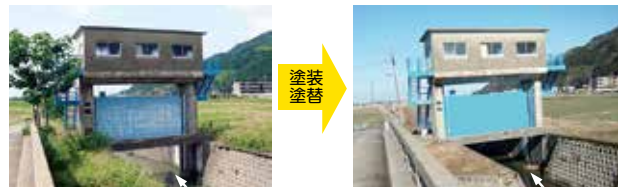
扉体の腐食防止対策
