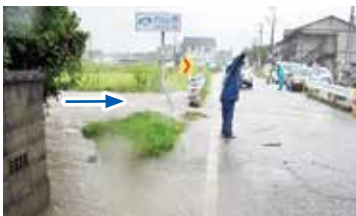
平成25年8月23日 浸水状況 浸水面積1.7ha
