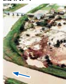
平成10年 9月22日 浸水状況
