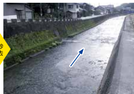
堆積土砂除去の事例（仁岸川：輪島市）
