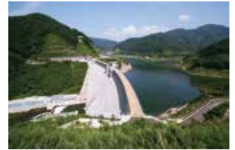
九谷ダム (加賀市)
