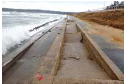
海岸保全施設の被災(H27.12 増穂浦海岸)
