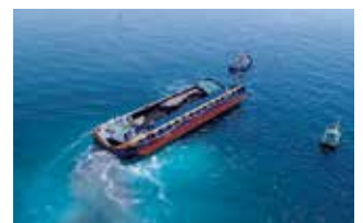
海上投入の実施状況 (砂の投入)
