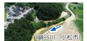
令和4年8月4日 浸水状況
