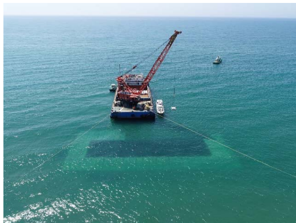
人工リーフ(羽咋地区)整備状況 実施期間: 2015(H27)~2022(R4)(完了)
