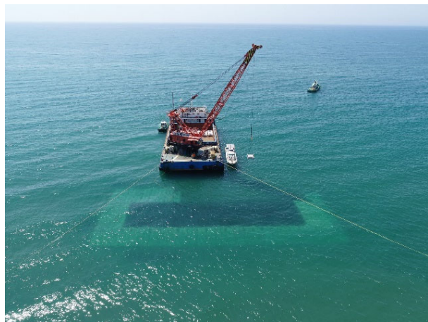
人工リーフ(羽咋地区)整備状況 実施期間: H27~
