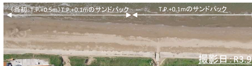
砂流出防止工(サンドバック) 実施期間: H24~H29
