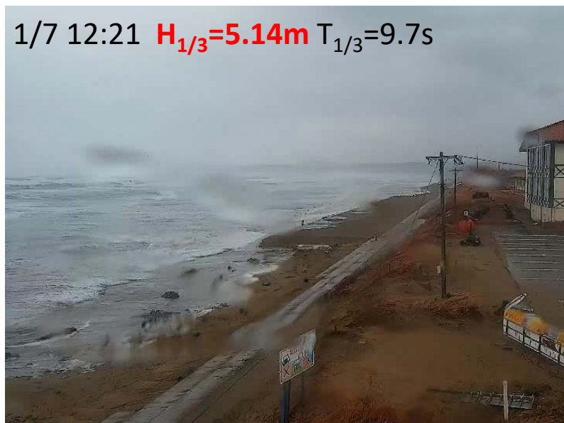
波の遡上状況(盛土①付近)
