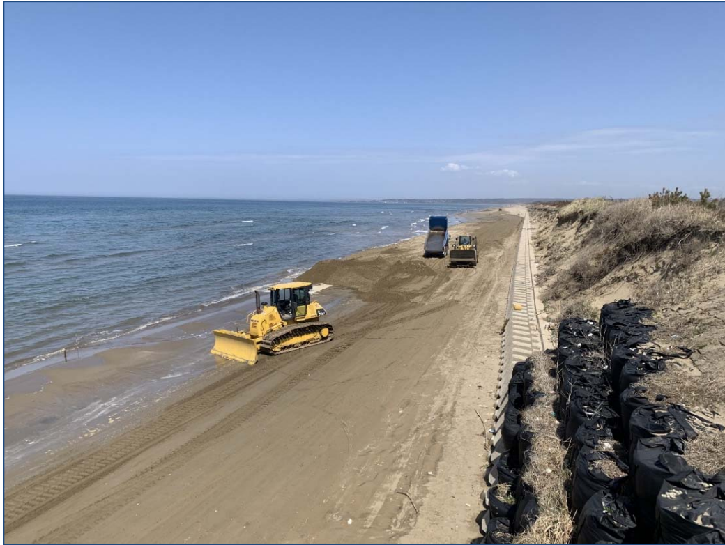
緊急養浜工事の状況
