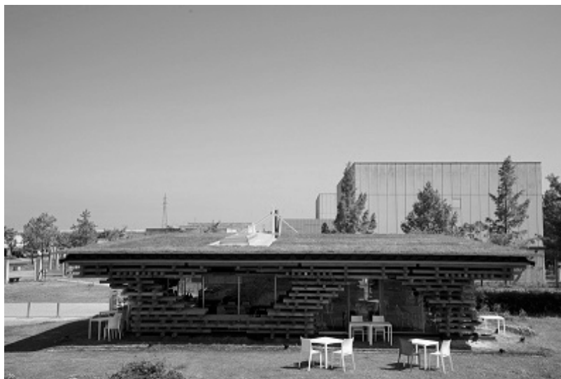
セダム屋上緑化施工例
