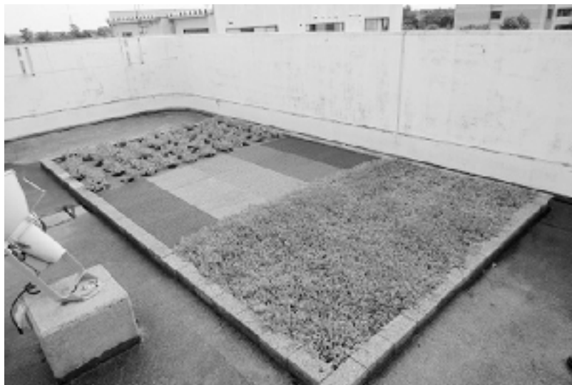
本社屋上のサンプル施工例
