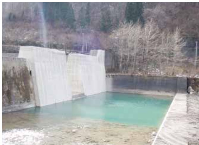
工事写真(砂防堰堤)
