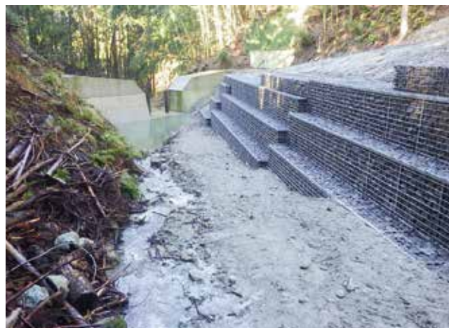
工事写真(山腹工事)
