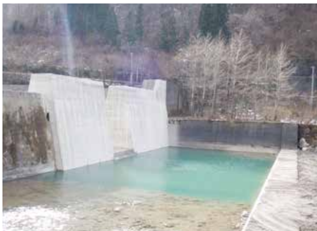
工事写真(砂防堰堤)
