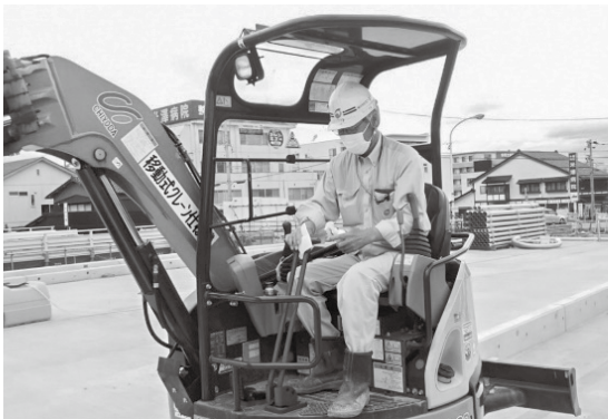
建設機械の定期的な消毒
