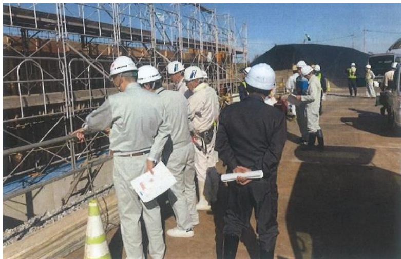
<工事現場合同安全パトロール>
