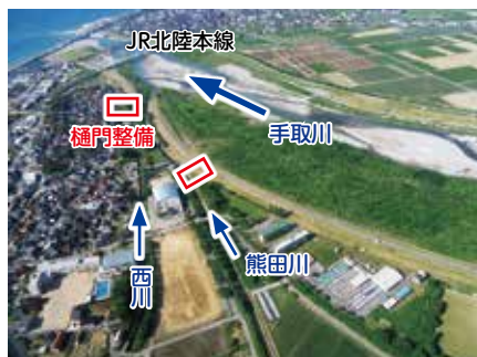
手取川（河口付近の樋門整備）
