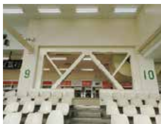
耐震ブレースの設置(金沢競馬場)
