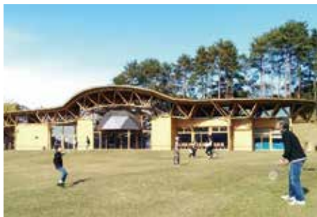
奥卯辰山健民公園 リニューアルされた管理棟
