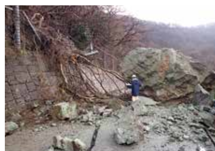
道路への落石 ((主)大谷狼煙飯田線 珠洲市高屋町)
