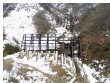
対策後の状況 (平成30年2月)
