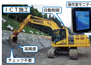
ICT建設機械の活用
