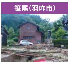
災害状況 人家土砂流入2戸 (平成26年8月17日)
