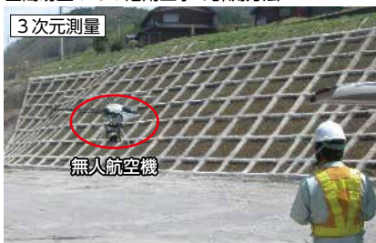
無人航空機で取得する3次元測量データを活用して、パソコン画面上で必要な寸法等を計測することにより、効率的で安全な施工管理ができます。
