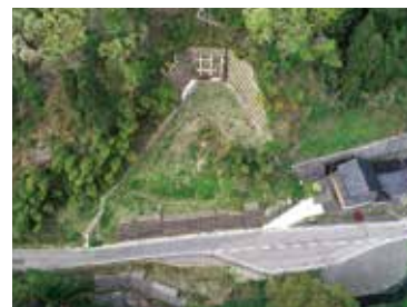
対策後の状況 (令和3年5月)
