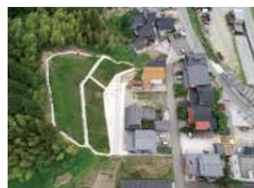
対策後の状況 (令和2年6月)
