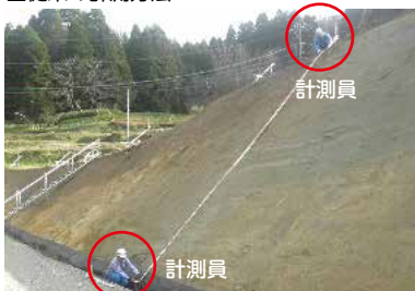
計測員が施工後の現場を測量しています。
