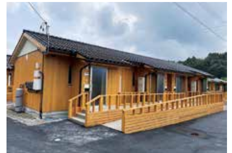
仮設住宅の建設(輪島市南志見地区)
