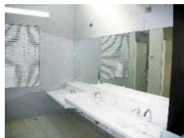
カウンター式洗面器の設置
