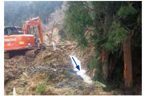
土砂ダムの撤去(輪島市町野町川西)
