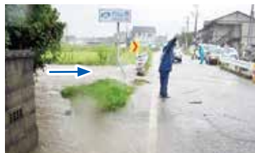
平成25年8月23日 浸水状況 浸水面積 1.7ha
