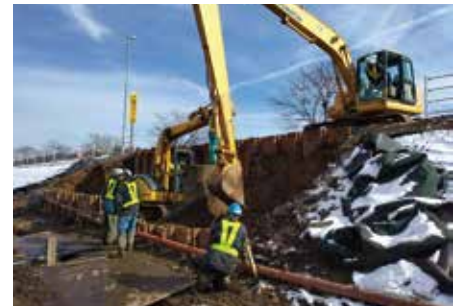
県水送水管の復旧(中能登町二宮)
