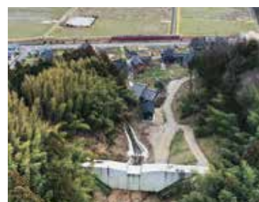
対策後の状況 (平成31年3月)
