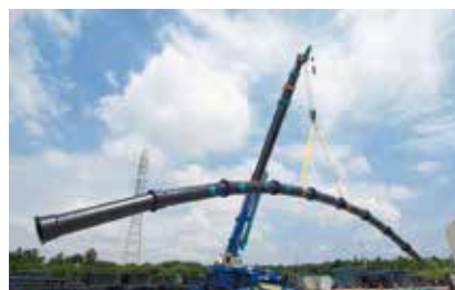
耐震性の高い送水管 (離脱防止テストの状況)
