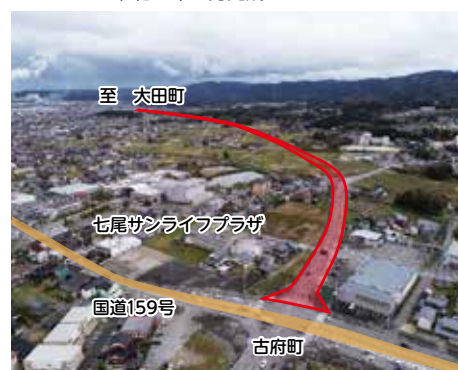
七尾外環状道路((都)外環状線)
