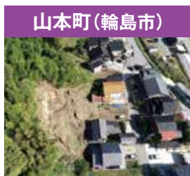
災害状況 家屋被災3戸 (平成30年9月10日)
