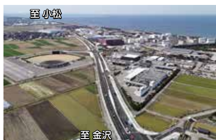
加賀海浜産業道路 (令和6年4月 4車線供用) (白山市小川町～松本町間)
