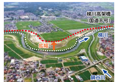
梯川（国道8号付近の拡幅）
