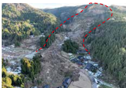
斜面崩壊(輪島市市ノ瀬町)
