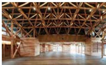
構造・内装材に木材を使用 (奥卯辰山健民公園管理センター)
