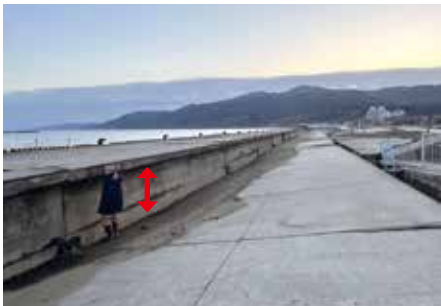
ふ頭の段差解消(輪島港マリンタウン)
