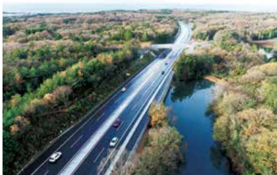
のと里山海道4車線化(羽咋市柳田町)
