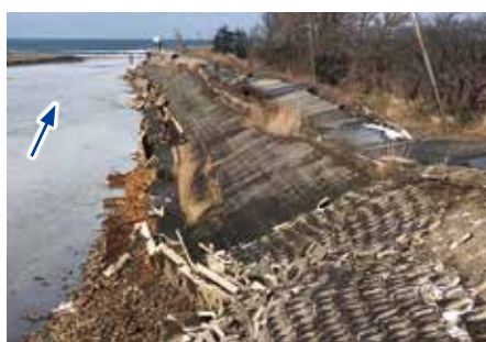
堤防沈下・護岸損壊(町野川 輪島市町野町管々木)
