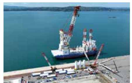
洋上風力発電設備取扱い状況
