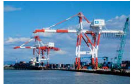
御供田国際コンテナターミナル（2基のガントリークレーン）
