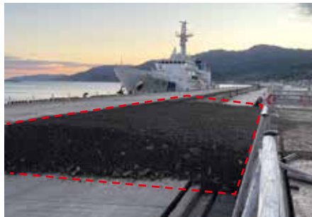
ふ頭の段差解消(輪島港マリンタウン)
