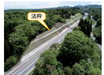
法面落石対策((主)七尾輪島線)
