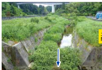
堆積土砂除去の事例（涌波川：金沢市北陽台2丁目）
