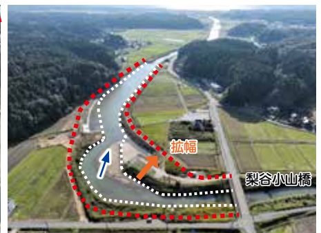
米町川（梨谷小山橋付近の拡幅）
