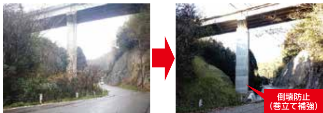
主要地方道志賀富来線 志賀町福浦港地内(水の溜橋)
