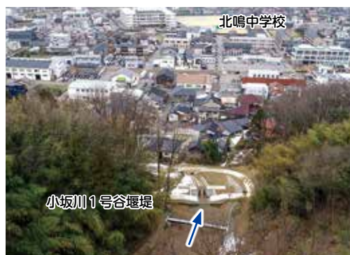
砂防施設の整備（金沢市小坂町）
