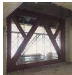
耐震ブレース設置中の様子
