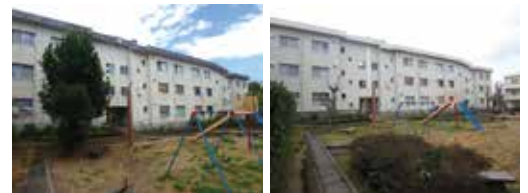
改修前 改修後 円光寺町団地（整備写真）（令和6年3月完成）
