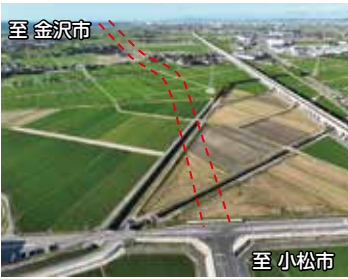
加賀海浜産業道路 白山市松本町～川北町橋
