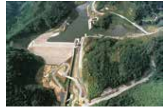
小屋ダム（珠洲市） 小屋ダムなど利水容量を有するダムを対象に事前放流を実施
