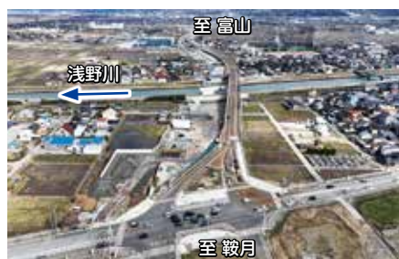
金沢外環状道路 海側幹線Ⅳ期 (令和4年11月 山側2車線暫定供用) (金沢市大河端町～福久町)
