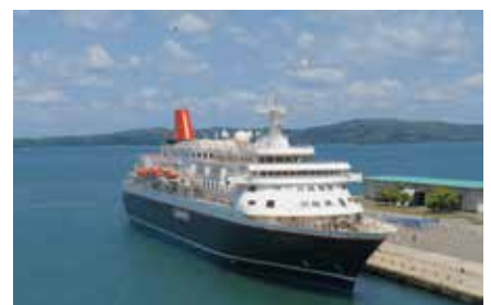
矢田新耐震強化（旅客船）岸壁 （クルーズ船：にっぽん丸）
