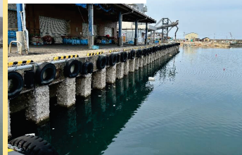
② 仮棧橋設置
