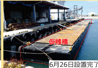
6月26日設置完了
