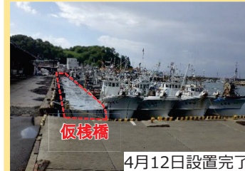
4月12日設置完了
