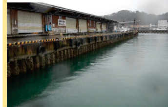
① 仮棧橋設置
