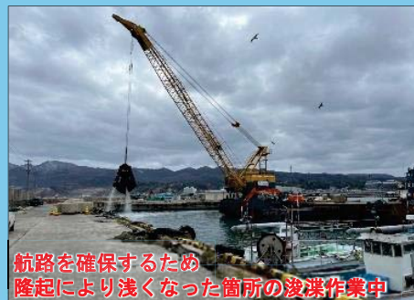
[A] 輪島港 航路啓開 (浚渫)
