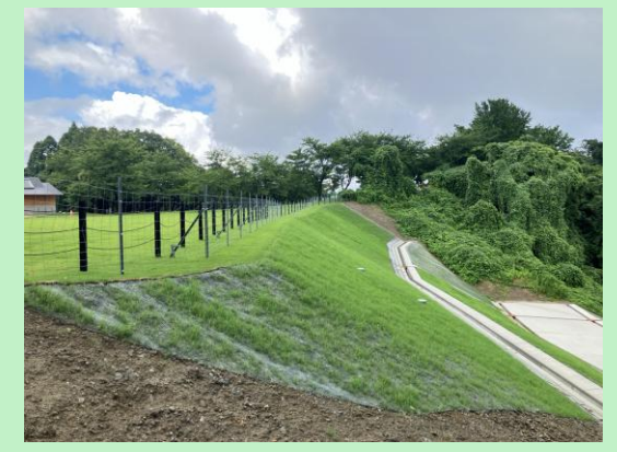
R8.8 復旧完了・利用再開
