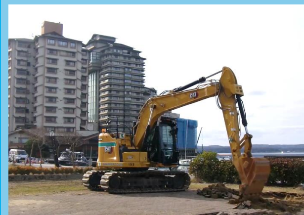
① 仮設道路の施工状況 (国代行区間)
