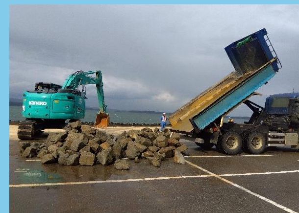
② 資材の搬入状況 (県施工区間)
