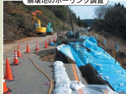
崩壊地のボーリング調査
