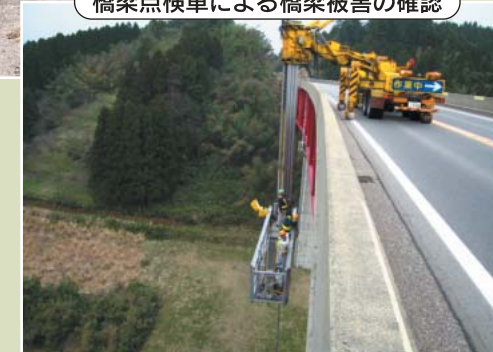
橋梁点検車による橋梁被害の確認
