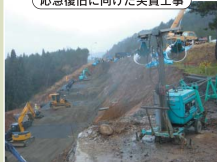
応急復旧に向けた突貫工事
