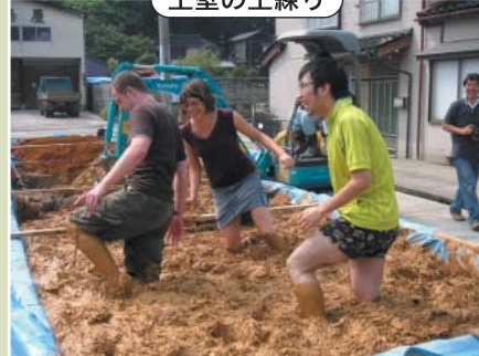
土壁の土練り
