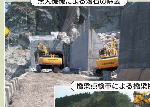
無人機械による落石の除去
