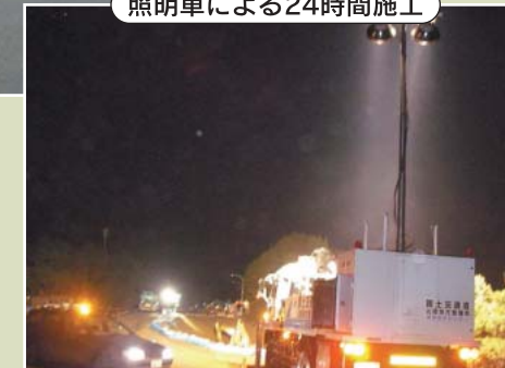
照明車による24時間施工
