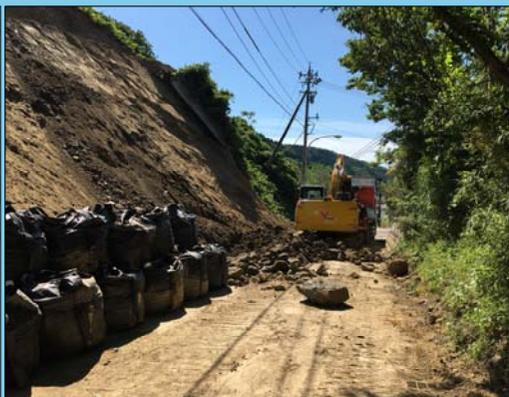
通行確保に向け崩土の除去作業中
