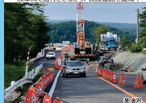
一般車両を通行させながら、仮設道路を造成中
