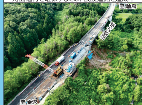
対面通行を確保するため、仮設道路を造成中
