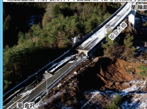
道路盛土の崩壊に伴い、路面に大きな損傷が発生
