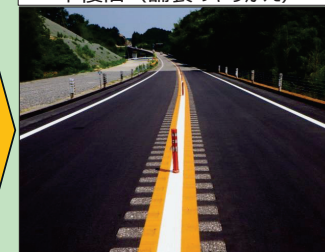
本復旧（舗装のやりかえ）
