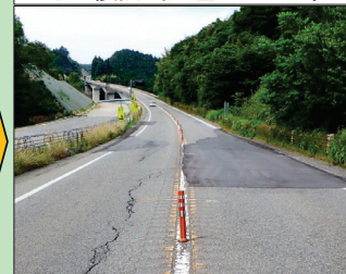
応急復旧（段差のすりつけ）
