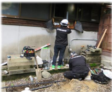
宅内配管工事の状況（輪島市内）
