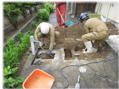
宅内配管工事の状況（七尾市内）
