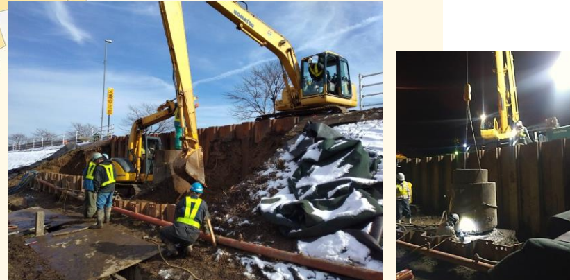
県水送水管の復旧作業
