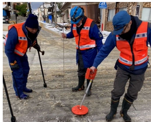
漏水調査(東京都水道局)
