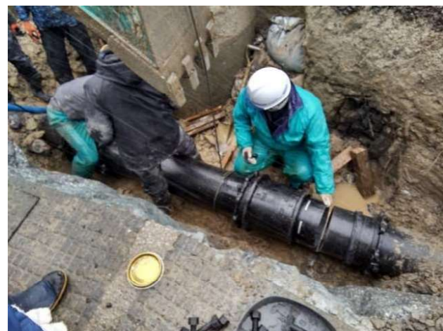
送水管損傷箇所の応急復旧
