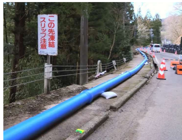
仮設配管による応急復旧
