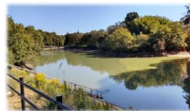
▲農業用ため池
