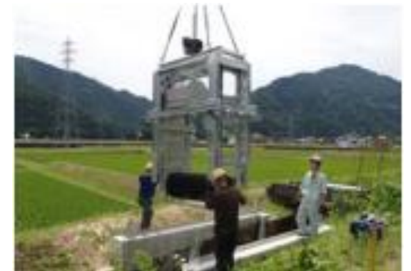
水車据付風景
