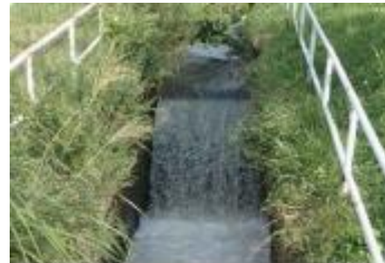
設置前の落差工
