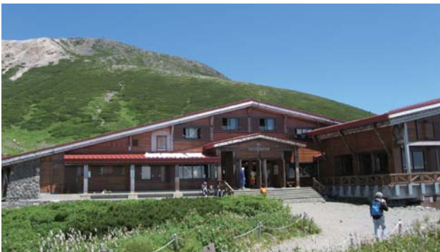
白山室堂ビジターセンター
