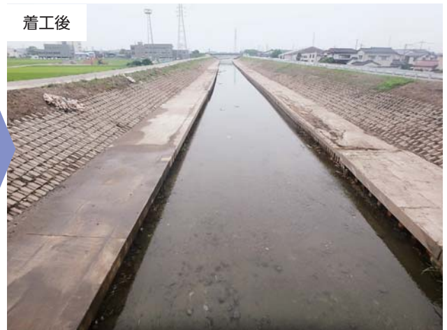
金腐川漆橋(下流)の堆積土砂除去
