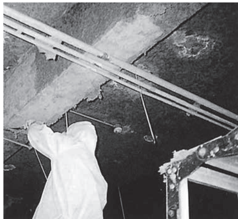
吹付け石綿の除去
