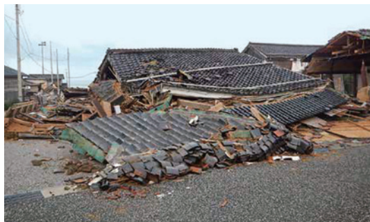
倒壊した家屋
