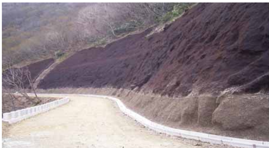
法面下部1.5mが木材チップ防草吹付工
