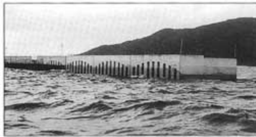
水質を良好に保つための海水交換型防波堤
