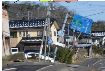
内灘町西荒屋地内 (液状化)
