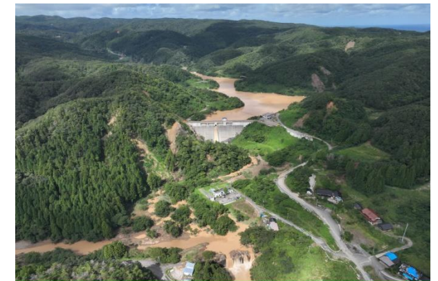
大規模法面崩落による道路の封鎖
