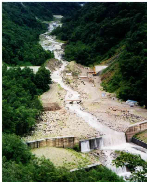
柳谷川につくられている砂防ダム 上流からの土砂を堆積している。
