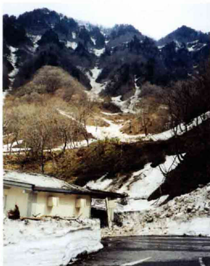
中宮展示館雪崩被害
