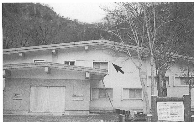
写真1 測定センサー設置点
