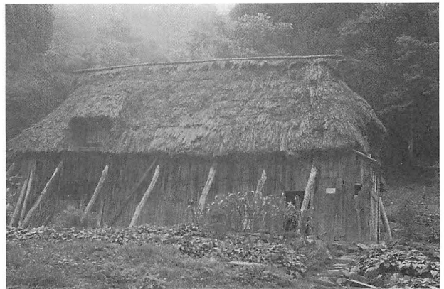
写真6 ツカセを施設した出作り住居 (赤谷・山口市次郎家)
