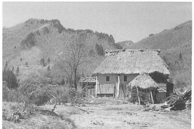
写真2 長坂吉之助家の母屋とセンジャ (手前) ヌケ小屋は、右前方に約25m 離れてあった。
