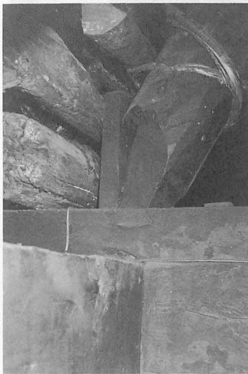
図14 合掌柱の末端、細くして力を1点に集中させ、外側に板と横材を当てて側圧を緩めている。梁材はヒメコマツ。
