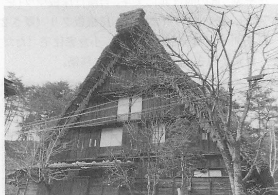
図5 岐阜県大野郡庄川村下瀧若山家全景
