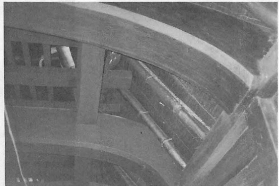
図12 根曲りスギの彎曲部を利用してアーチ構造とし圧力の分散をはかっている。(宮川家)
