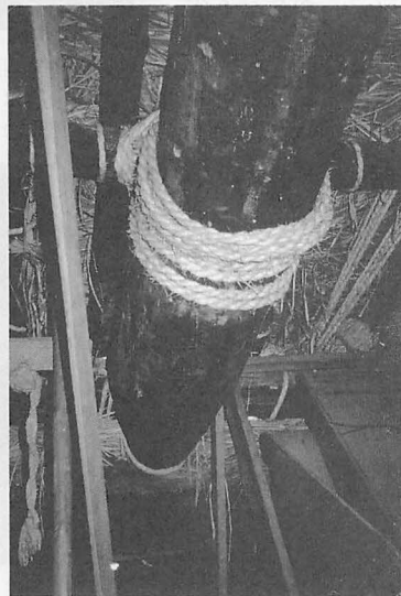
図15 福井県大野郡和泉村荷暮大久保家の合掌柱の根部、梁に穴を穿ち、柱の根端を尖らせと穴にはめこんである。細い棒は農具の柄。
