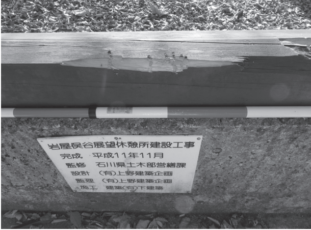
写真5 2010年以降の被害※右端が繰返し部分
