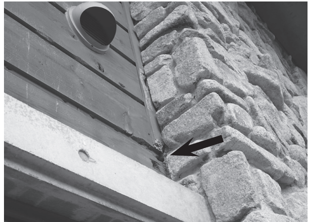
図2 矢印は市ノ瀬ビジターセンター外壁の孔
